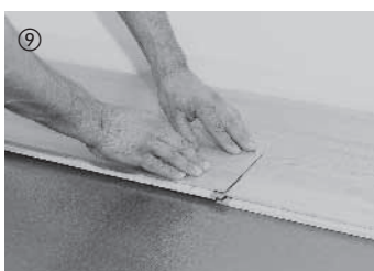
Anschließend wird das Element stirnseitig abgesenkt. Beachten Sie hierbei, dass das Element stirnseitig bündig an das zuvor verlegte Element anstößt. Durch kurzen Druck auf den Querstoß rastet das Element ein.
