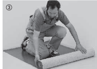
Zur Trittschalldämmung und zum Ausgleich kleiner Unebenheiten wird eine 2 mm dicke Komfort-Dämmunterlage bündig ausgerollt. Geeignete Dämmunterlagen finden Sie in unserem Zubehörangebot. Bitumenpappe eignet sich nicht zur Trittschalldämmung. Parkettboden mit aufkaschierter Dämmunterlage ist für eine vollflächige Verklebung nicht geeignet.
