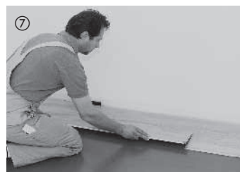
Mit dem Reststück der ersten Reihe wird in der nächsten Reihe wieder begonnen (stirnseitiger Versatz von mindestens 50 cm). Dadurch wird der Verschnitt erheblich reduziert. Die weitere Verlegung erfolgt elementweise. Dazu werden die Elemente zuerst längsseitig mit leichtem Druck in die Verbindung eingedreht.
