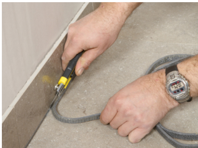
11) ... um ihn im nächsten Arbeitsschritt mit einem Trapezmesser abschneiden zu können.
