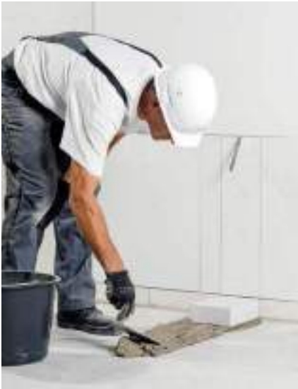
Bild 33 Mörtel auf die Betonsohle auftragen
