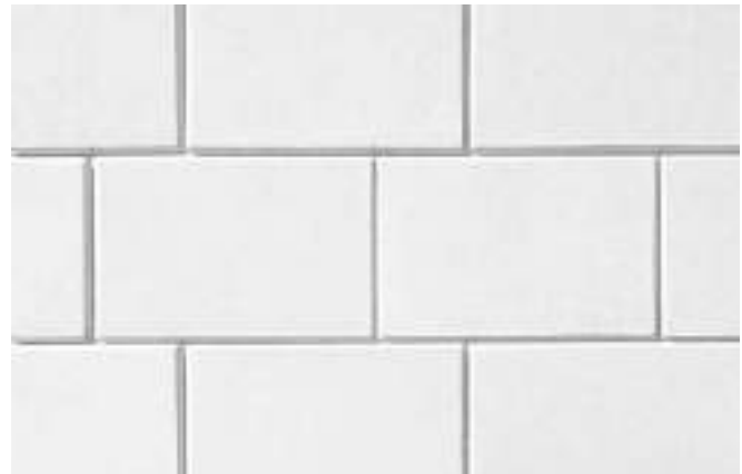
Bild 4 Sichtmauerwerk aus KS-Fasensteinen, außen in Verblenderqualität und mit vermörtelten Stoßfugen
