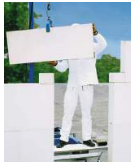
Bild 28 KS-Fertigteilstütze für großformatiges Mauerwerk
