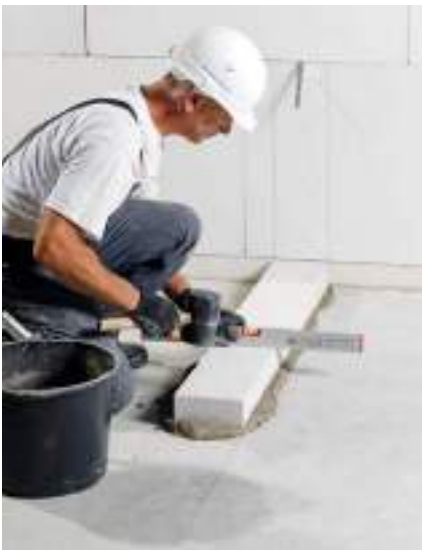
Bild 35 Kimmsteine in Querrichtung ausrichten
