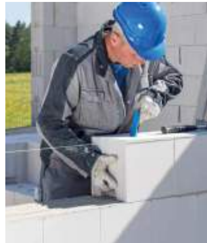
Bild 21 KS -R-Plansteine für Dünnbettmörtel
