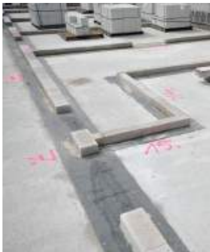
Bild 22 Anlegen der Kimmerschicht
