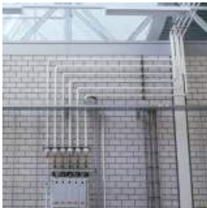
Bild 2 Innensichtmauerwerk aus Kalksandstein mit befestigten Installationsleitungen
