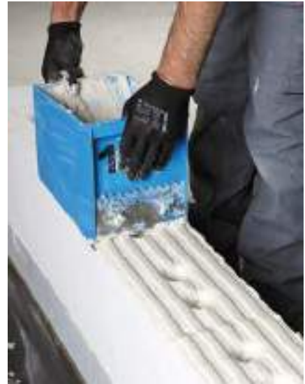
Bild 39 Auftragen des Mörtels für die Lagerfuge
