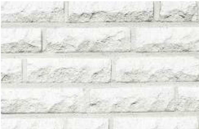
Bild 3 Sichtmauerwerk aus bossierten KS-Verblendern, Format NF, weißer Fugenmörtel
