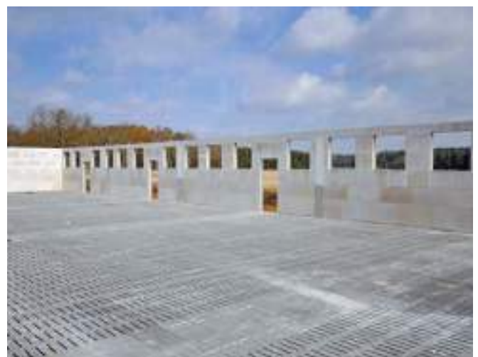
Bild 49 Rohbau eines Maststalls
