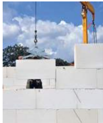
Bild 24 Vermauern von KS XL-Plan-elementen
