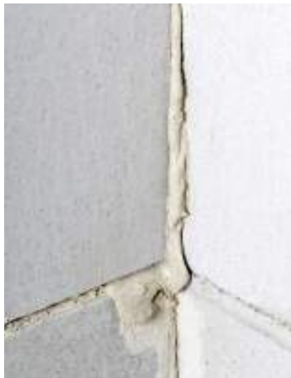
Bild 41 Vollfugiger Stumpfstoßanschluss mit Dünnbettmörtel vor dem Abstreichen
