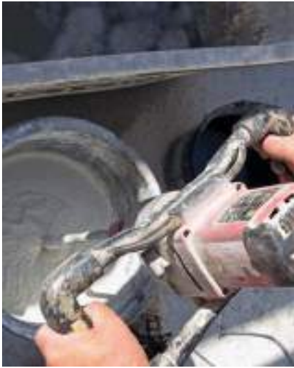
Bild 2 Anmischen von Dünnbettmörtel
