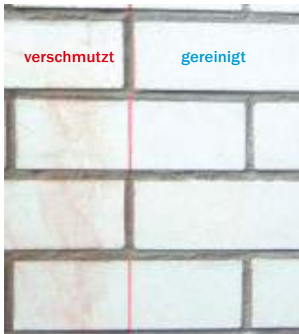
Bild 12 Reinigungseffekt, Beispiel Reinigung mit Schleifpapier, Körnung 140
