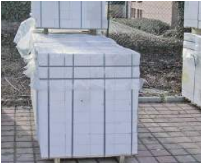
Bild 19 Lagern von Steinen mit Schutz gegen Niederschlag
