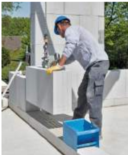
Bild 23 Vermauern von KS XL-Raster-elementen
