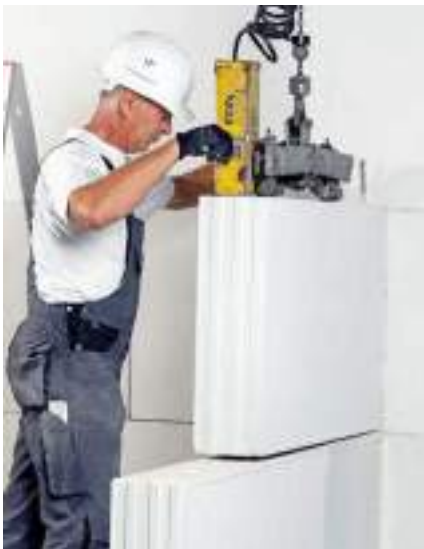
Bild 40 Versetzen eines XL-Elements
