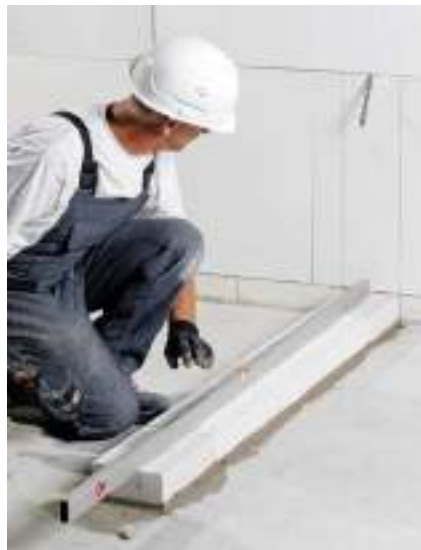
Bild 36 Kimmsteine in Längsrichtung ausrichten
