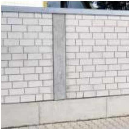
Bild 50 Frei stehende KS-Wand mit Aussteifungen
