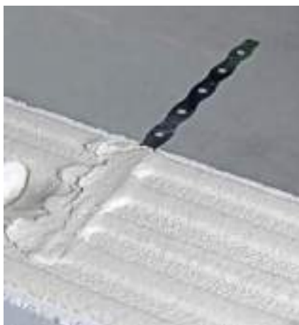
Bild 35 Stumpfstoßtechnik: Mörtelbett mit Edelstahl-Flachanker
