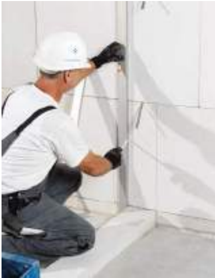
Bild 37 Anreißen der zu erstellenden Wand
