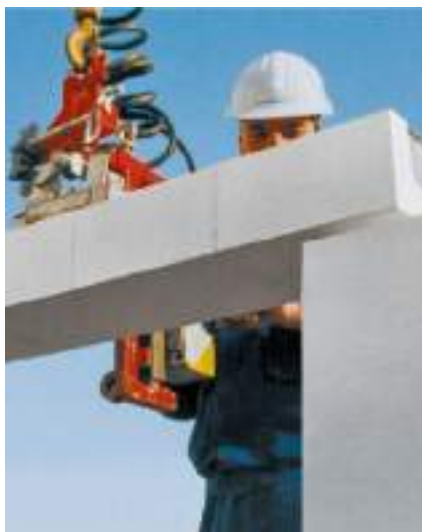
Bild 27 Vorgefertigte KS-Flachstütze zur schnellen und rationellen Öffnungsüberdeckung
