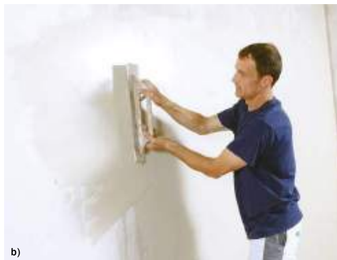
Bild 9 Arbeitsschritte beim Verputzen einer Wand; a) Auftrag des Putzmörtels; b) Glätten des Putzes
