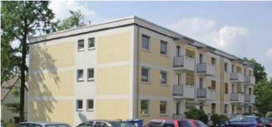
Bild 23 Mehrfamilienhaus aus KS-Mauerwerk mit WDVS aus dem Jahr 1968
