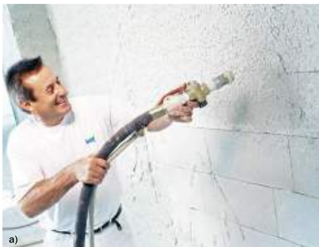
Bild 9 Arbeitsschritte beim Verputzen einer Wand; a) Auftrag des Putzmörtels; b) Glätten des Putzes
