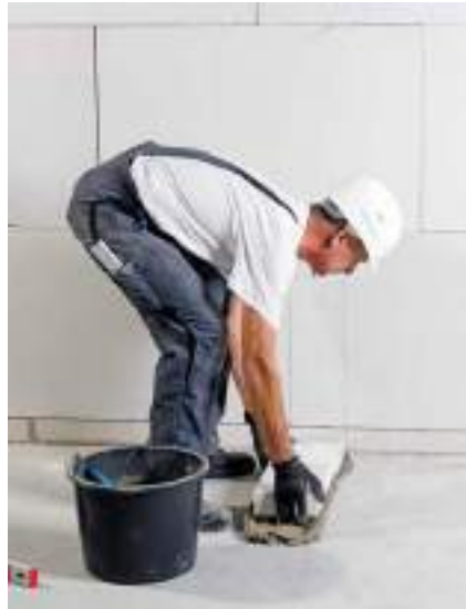
Bild 34 Kimmsteine ins Mörtelbett verlegen
