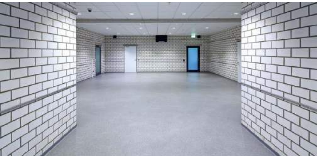
Bild 21 Halbstein-Überbindung minimiert Rissrisiko
