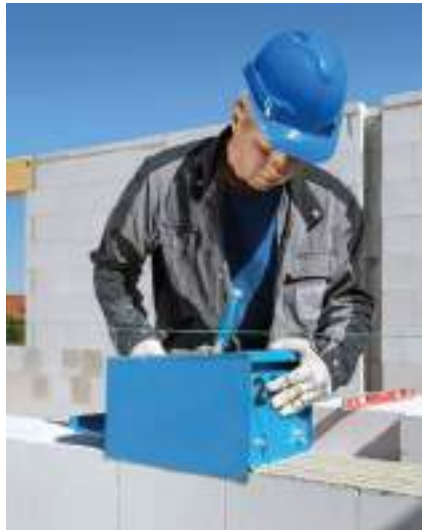
Bild 3 Mörtelauftrag mit Mörtelschlitzen
