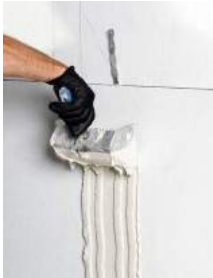
Bild 38 Mörtel für Anschlussfuge auftragen
