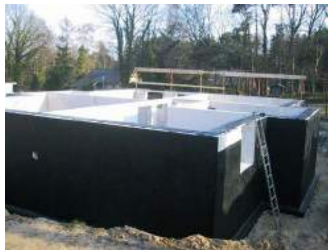
Bild 6 Kellerwand-Außenseite mit PMBC-Abdichtung
