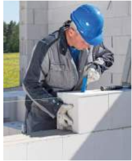
Bild 4 Versetzen von KS -R-Plansteinen in Dünnbettmörtel
