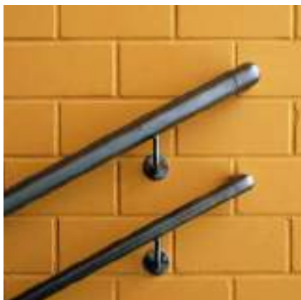
Bild 1 Befestigung von Treppengeländern an KS-Mauerwerk
