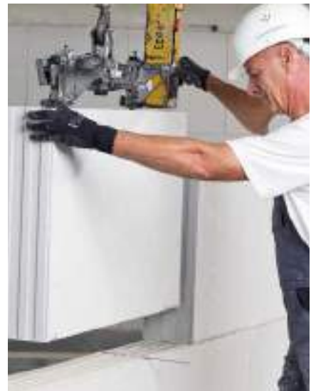
Bild 42 Versetzen der folgenden Elemente
