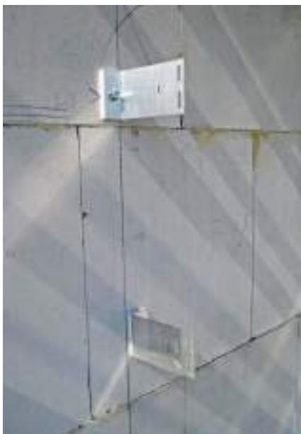
Bild 36 Aluminium-Unterkonstruktion mit Wandhaltern
